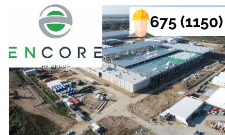
Завод «ЭнКОР» (Калининградская обл.)
